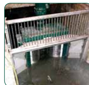
Прътова рамка от неръждаема стомана при преливане
