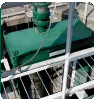
Channel Monster модел CDD на входа на ПСОВ и ПП
